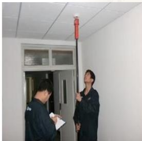
消检——检测烟感探测器
